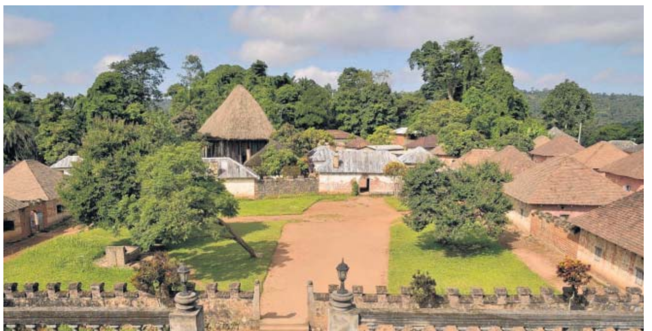
Komplett aus Holz: Was aussieht wie ein kleines Dorf, ist der Palast von Bafut. Die zahlreichen Gebäude sind um das Achum-Heiligtum angelegt.
